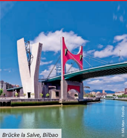
Brücke la Salve, Bilbao
