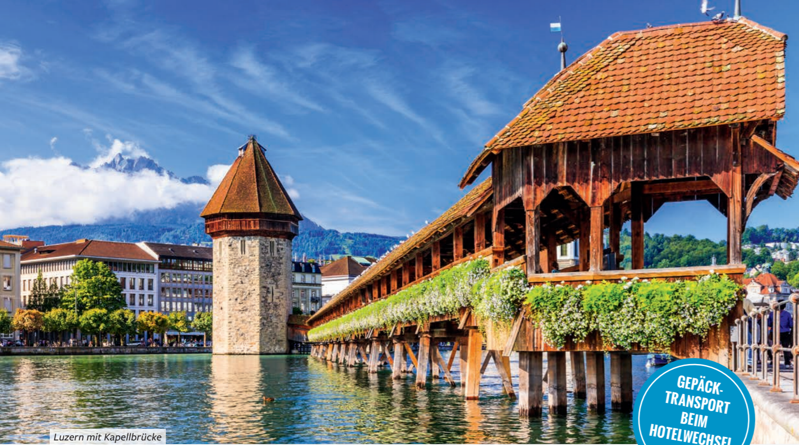
Luzern mit Kapellbrücke
